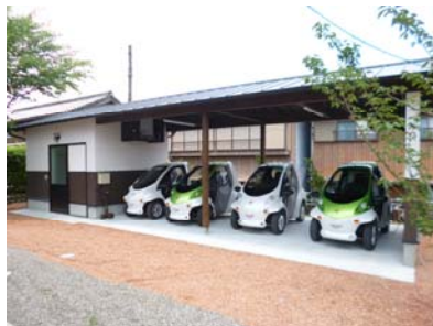
防災トイレ・蓄電池・コムス
